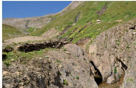
Abb. 19: Halb zerfallene Stützmauer
